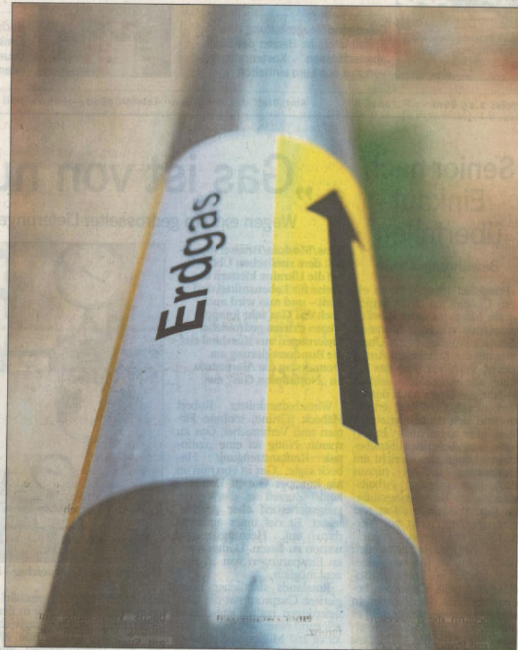
Gasleitung auf der Baustelle: Experten raten, bei Neubauten voll und ganz auf erneuerbare Energien zu setzen.
